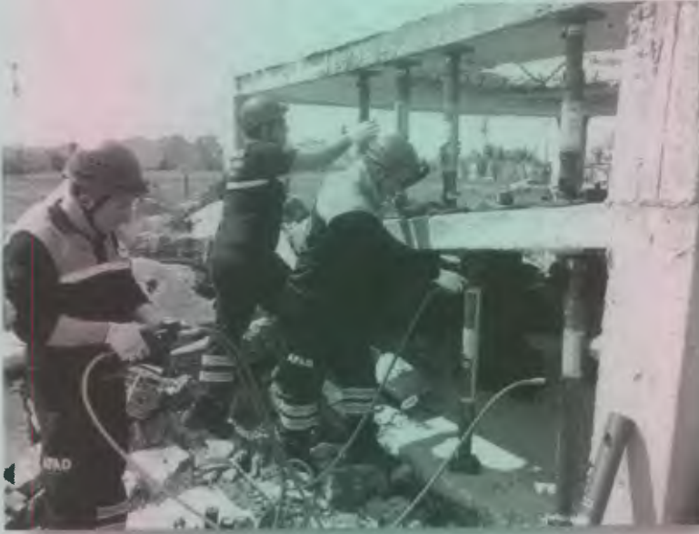
Resim 21: binada çökmeyi engellemek için yürütülen destekleme çalışması
