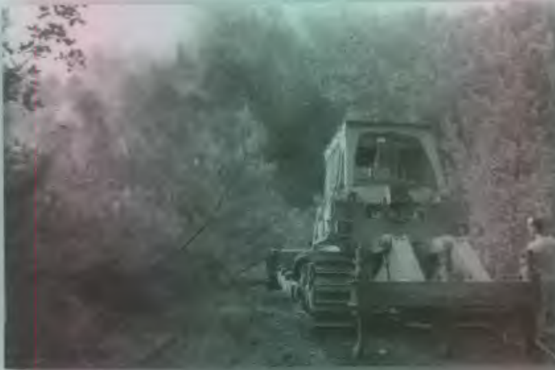
Resim 40: Yangında iş makineleriyle ağaçsız bölge oluşturma faaliyetleri
